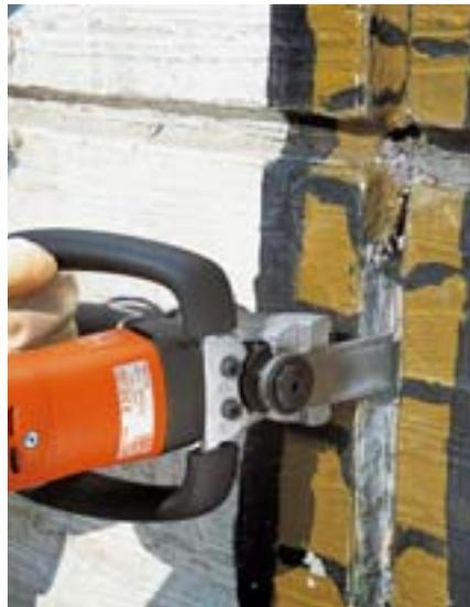
Travailler en toute sécurité avec FEIN : le dispositif d'aspiration réduit nettement la charge polluante dans l'environnement de travail immédiat. La poignée en forme d'étrier réduit les vibrations et permet de travailler sans se fatiguer.
