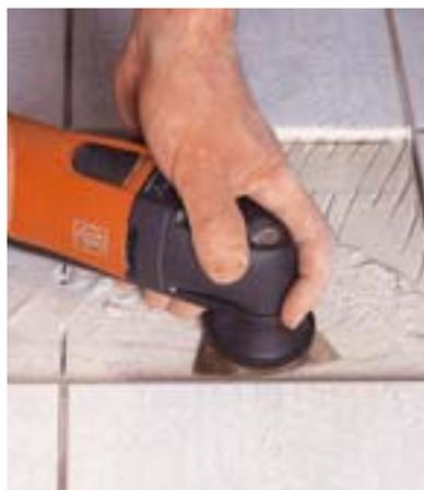
Poncer à plat les restes de crépi, de ciment, de colle à carreaux avant la pose du nouveau carrelage. En combinaison avec l'aspiration, un travail propre.
