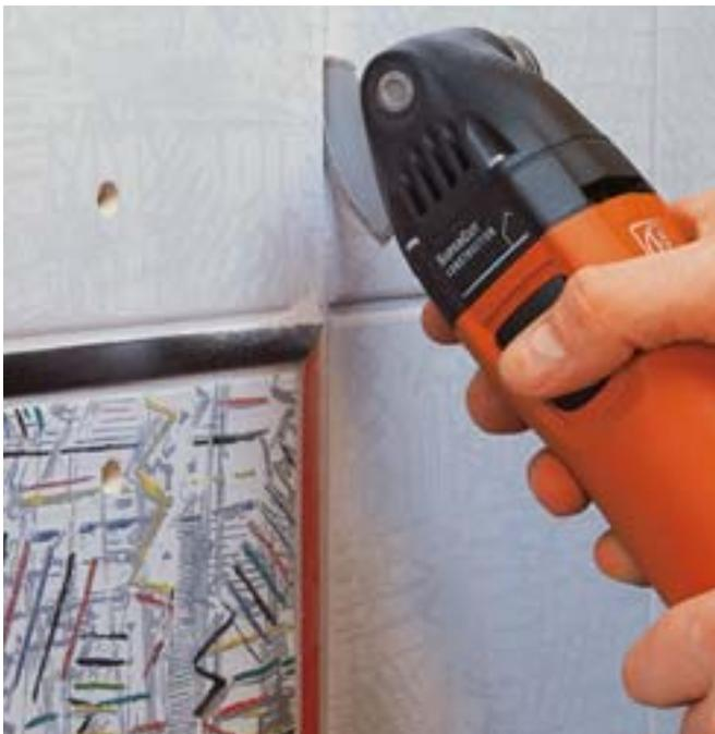
La lame segment diamantée coupe les joints en marbre, résine époxy et ciment. Les carreaux peuvent ensuite être éclatés et enlevés sans difficultés.
