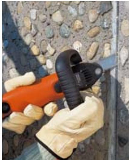
La lame de nettoyage diamantée permet de nettoyer et de gratter les flancs avant la pose du nouveau joint.
