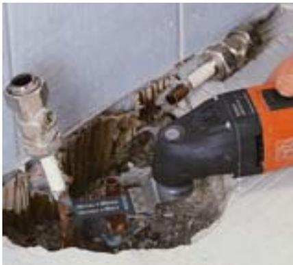
Les lames de scie universelles E-CUT à moyeu déporté permettent de scier à plat contre le mur ou sur le sol les tuyaux de chauffage en cuivre même aux endroits difficiles d'accès.
